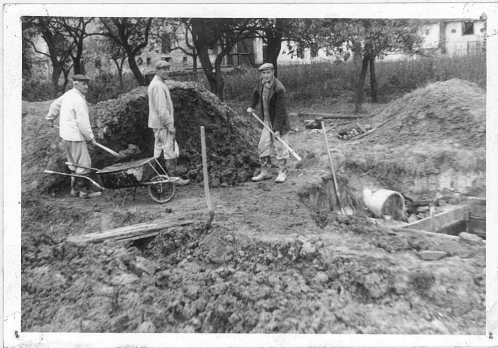
Skupina důchodců při „Akci Z“ - kanalizace při betonování odpadní jímky u transformátoru: Mráz, Zavadil, Smrž.
