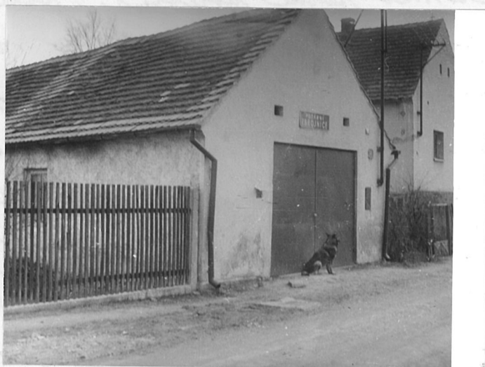
Budova požární zbrojnice č.p. 115 po generál. opravě.
